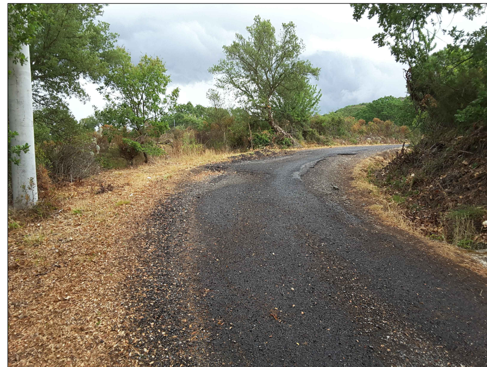
FOTO STRADA 1 (interventi puntuale su tratto in curva)
