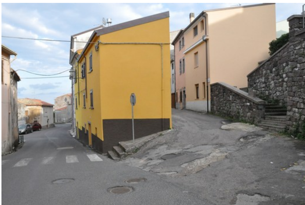
Foto n. 5 - Via Mazzini – (Incrocio con Via Nazionale)
