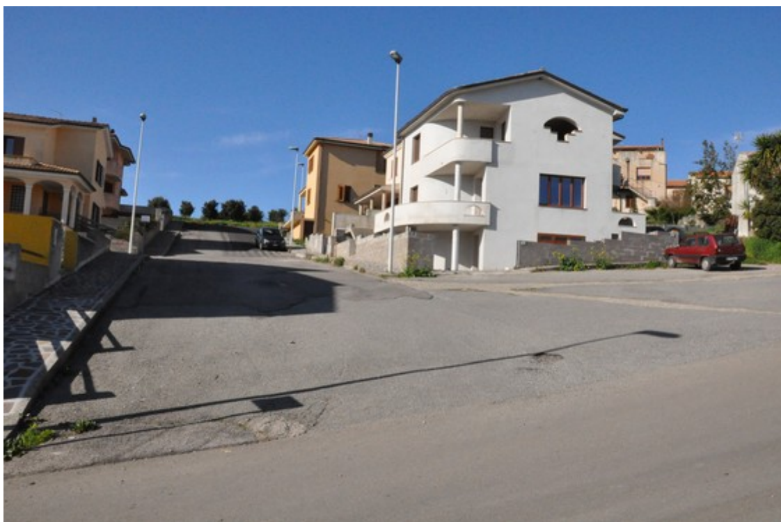
Foto n. 29 - Via E. Loi-Via Arborea
