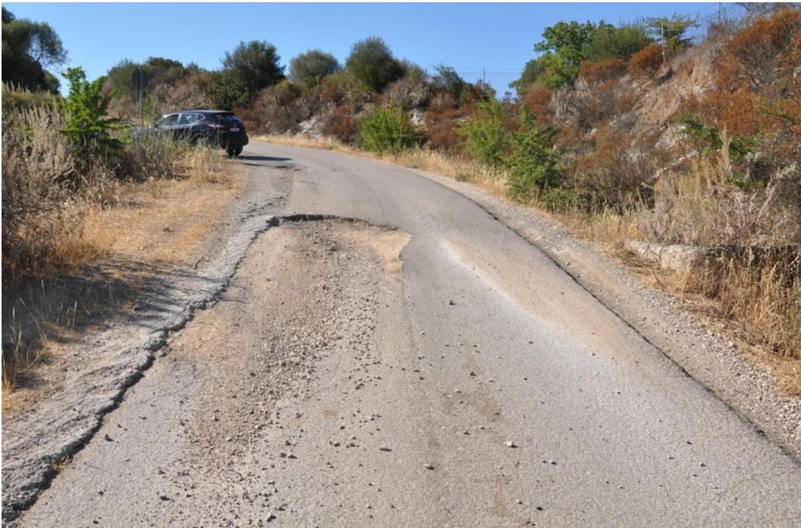
*Foto n. 17 (rifer. Com.Metr.Estim) – Conglomerato bituminoso “Scavo e Binder”*
