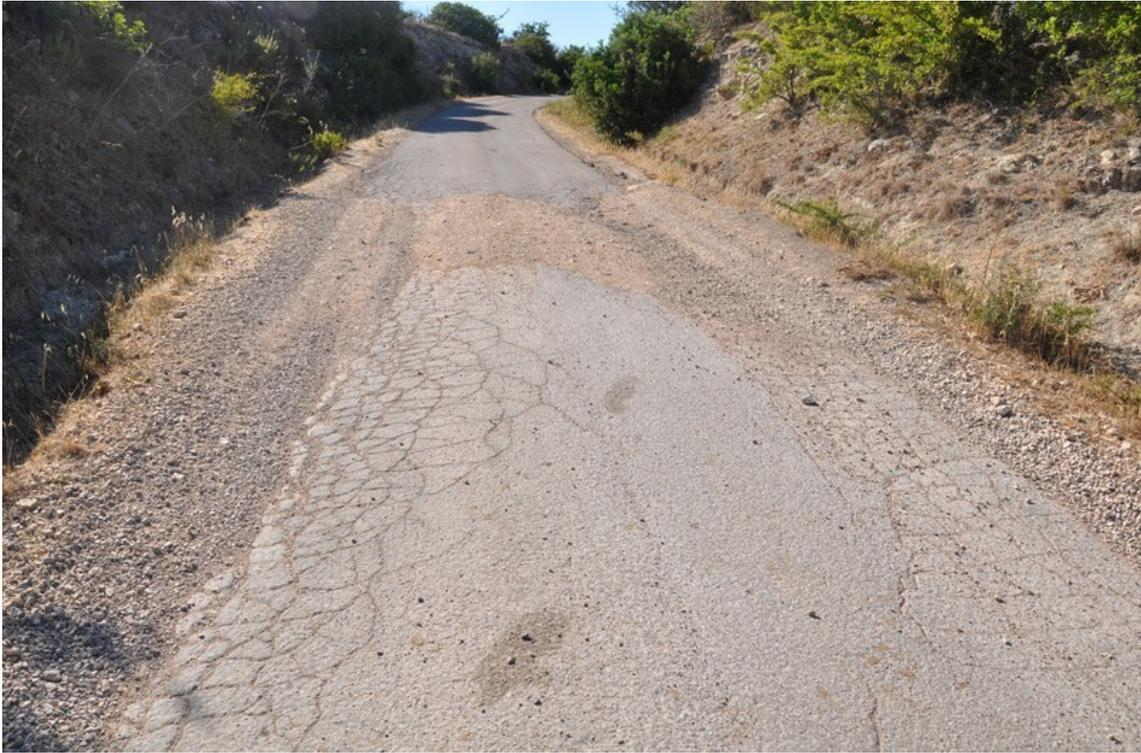
*Foto n. 20 (refer. Com.Metr.Estim) – Conglomerato bituminoso “Scavo e Binder”*
