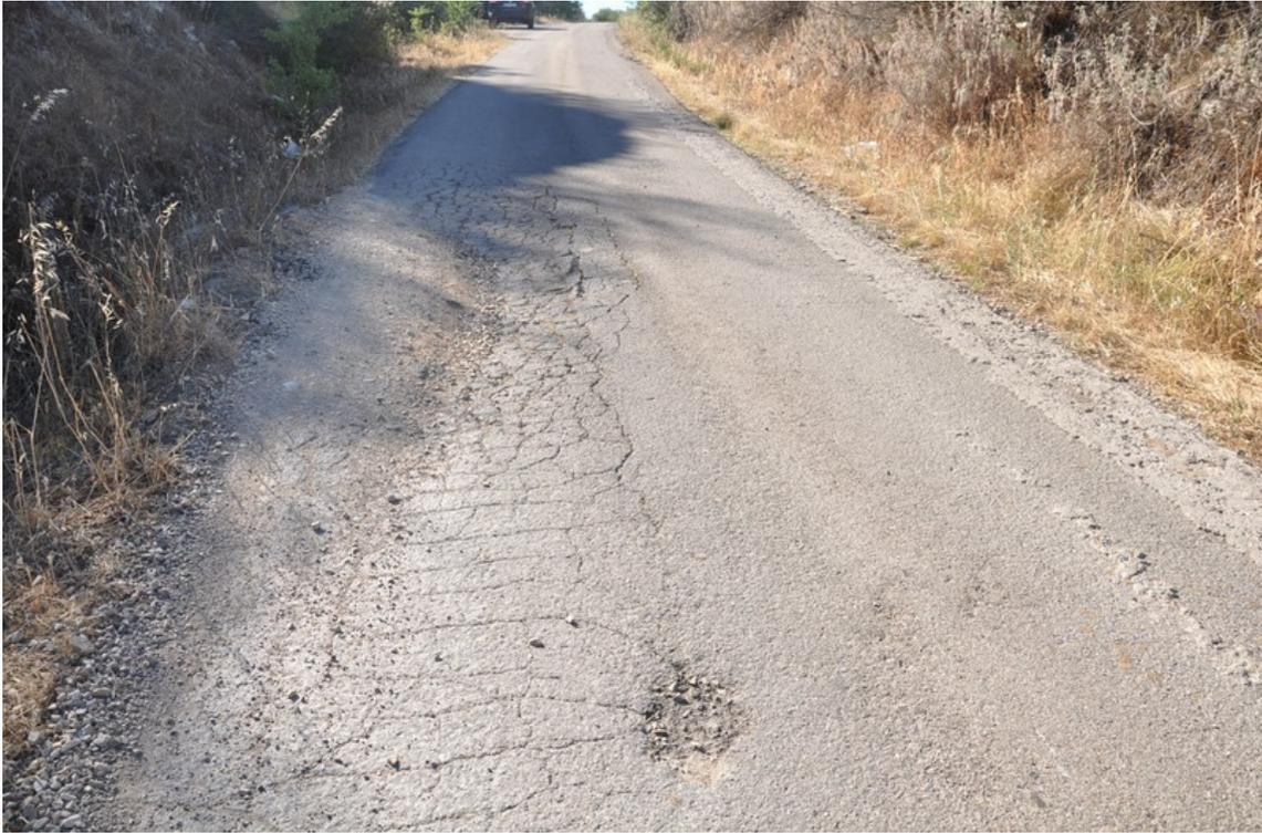
*Foto n. 18 (rifer. Com.Metr.Estim) – Conglomerato bituminoso “Scavo e Binder”*
